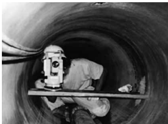
写真－1 管内手動測量
