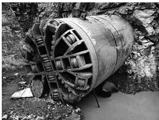
写真-1 岩盤での到達状況
