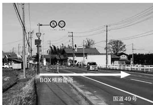
写真-1 現場状況
