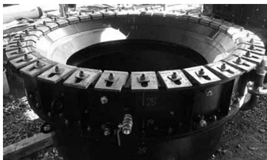
写真－1 ドッグレッグパッキン発進坑口
