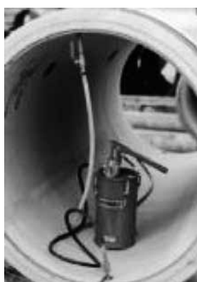
写真-1 注入ポンプ取付け例
