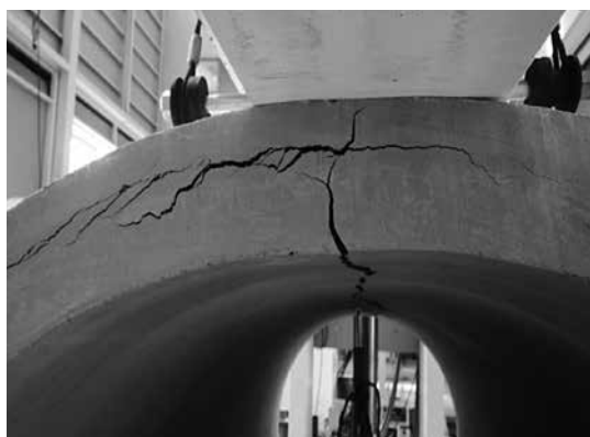
写真－3 鉄筋コンクリート管の破壊状況（参考掲載：比較用）
