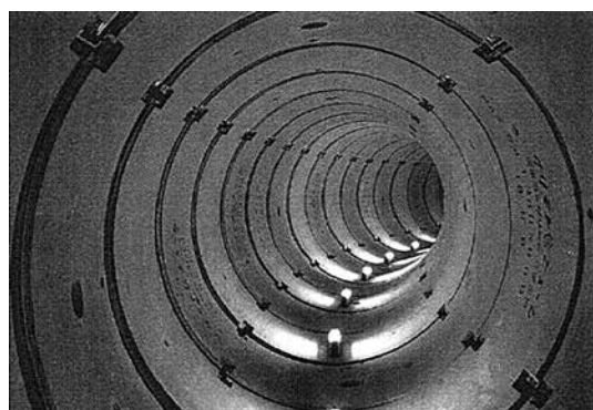
写真-2 目地開口抑制装置使用例
