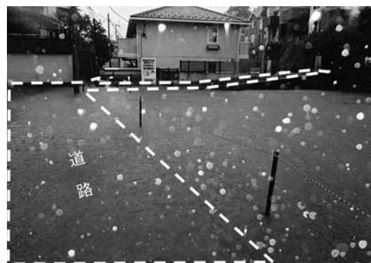
写真-1 浸水状況
