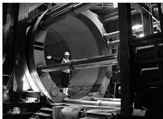
写真－1 超大口径管推進の施工（呼び径4000、管内人物は筆者）
