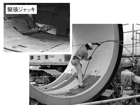
PC鋼線の挿入状況
