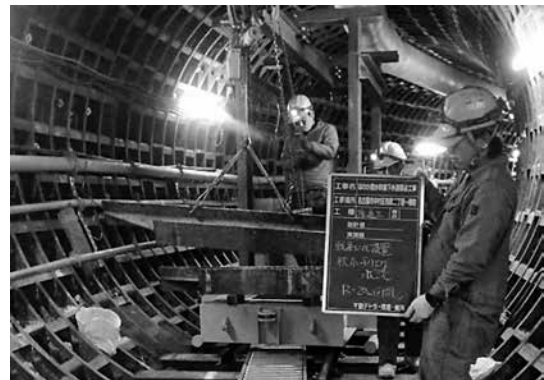
写真-1 枕木用鋼材吊下ろし状況
