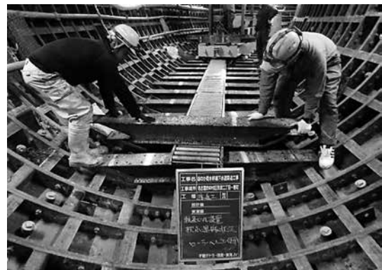
写真-2 運搬・設置状況
