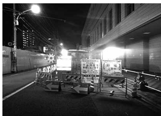
写真-1 夜間作業帯
