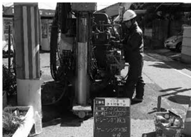
写真-2 ケーシング打設工
