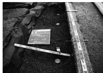
写真-5 ドレーン埋設後
