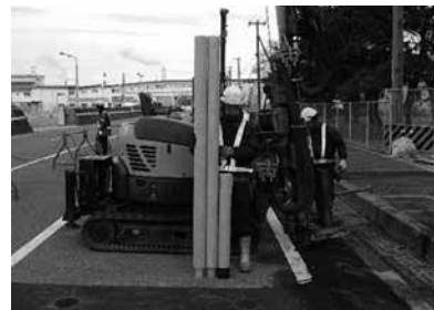
写真-4 埋設ドレーン材
