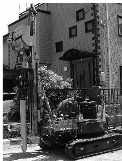
写真-1 ドレーン打設機（DN-3）
