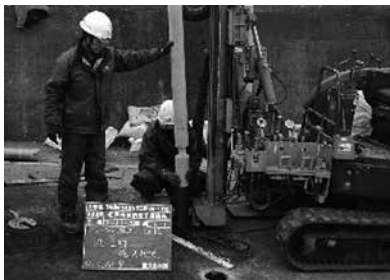
写真-3 ドレーン挿入状況
