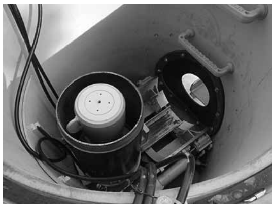
写真-1 KRMジャッキ1号マンホール据付け
