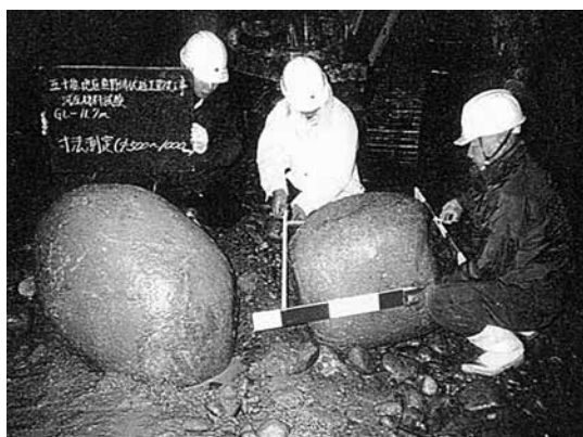
写真-1 立坑掘削時に確認された巨石
