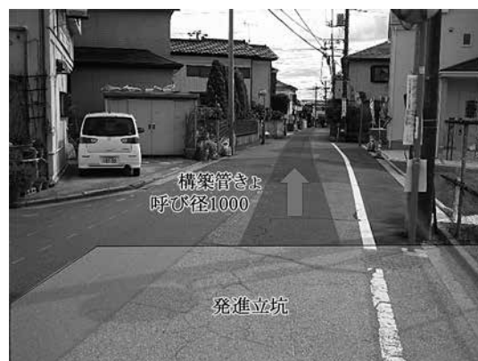
写真-1 工事箇所（発進立坑～到達）
